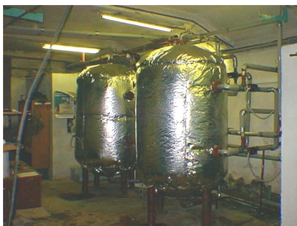
Рис. 1. Блок солнечных коллекторов Рис. 2. Баки-аккумуляторы горячей воды гелиоустановки СГУ по ул. Советской, 26-а
