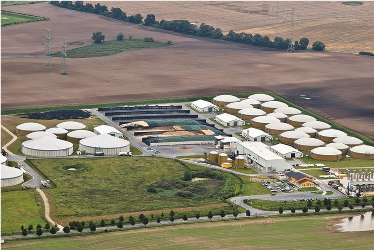
Рис. 3. Биоэнергетическая станция Nawaro Bio-Energie Park Güstrow в Германии
